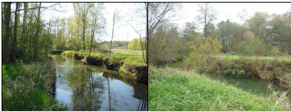
Obr. 10: Prohloubené koryto (foto Š. Tůmová 2016, 2017)
