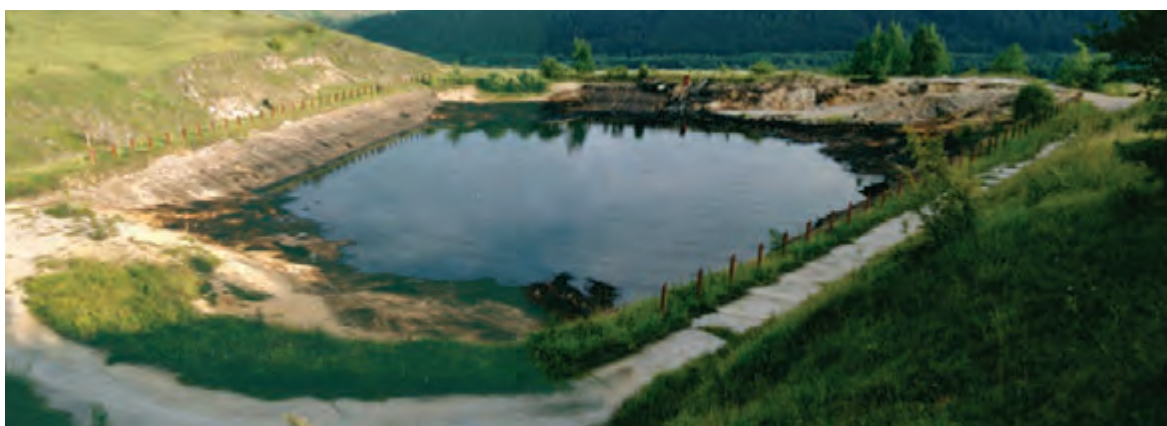
Obr. 1 Skládka gudrónov Predajná II (foto H. Ollerová)
