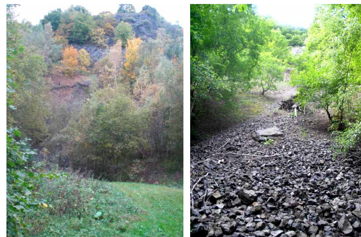
A – Celkový pohled na vrch Třtín od jihu (foto M. Holec 6. 10. 2010), B – detailní pohled na povrch kamenité akumulace ve svahu lomu (foto M. Holec 19. 6. 2011)
